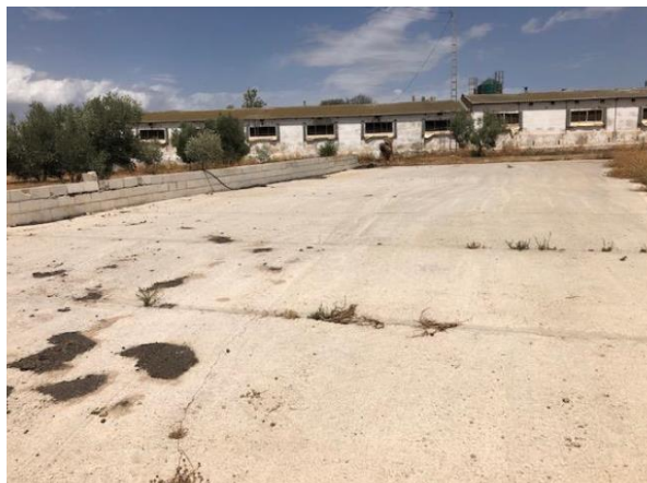
Figura 22: Plataforma impermeabilizada para estiércol.
